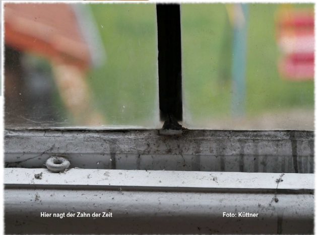
An der Bleiverglasung sichtbare Alterserscheinungen
